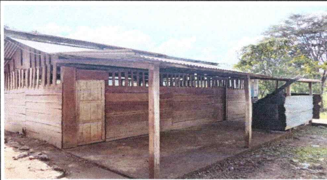
Foto 1: Reparacion de cocina
