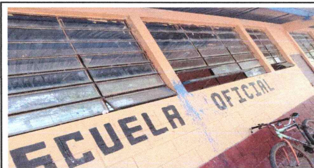
Foto 5: Reparacion de ventanas del modulo 1
